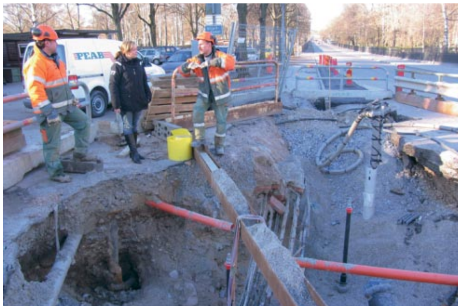
Tomas Weman och Mats Björk på Peab Anläggning, har jobbat med provtryckningsarbetet vid rörläggningen av Norrvattens dricksvattenledningar mellan Karolinska Universitetssjukhuset och bostadsområdet Blåkulla i Hagalund, Solna. Läckagetestningen gjordes med TKIG:s automatiska provtryckningsmaskin. Susanne Cederberg, Siemens, ansvarade för S7-200-styrsystemet och GPRS-kommunikationen.
